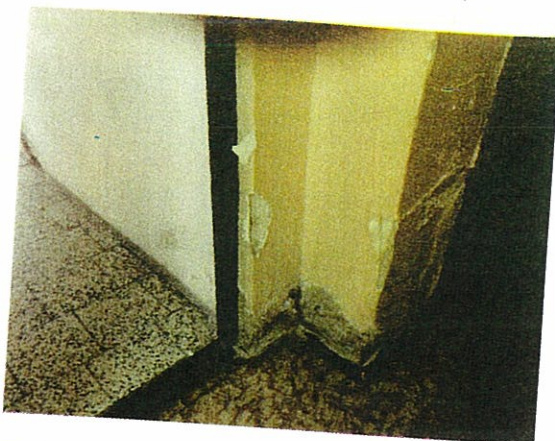
Chodby – porucha izolácie proti vode.
