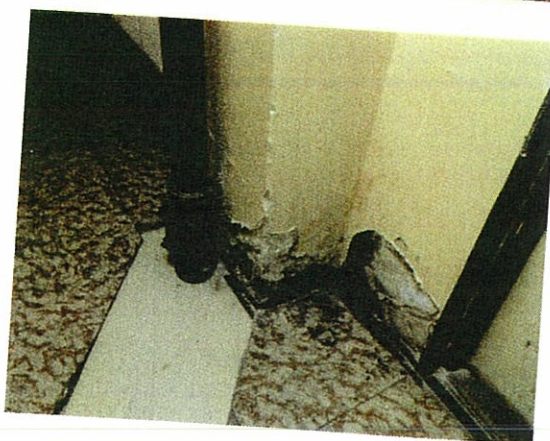
Chodba – porucha izolácií proti vode.
